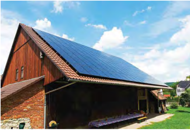
شكل ١٣: نماذج لتركيبات الأسقف المائلة
