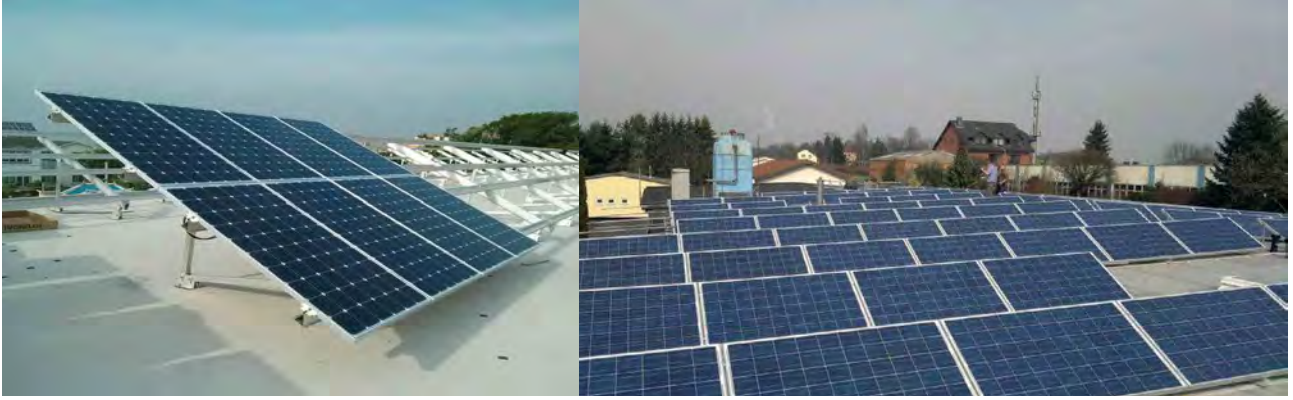
شكل ٦: تركيبات نموذجية للأسقف المسطحة
