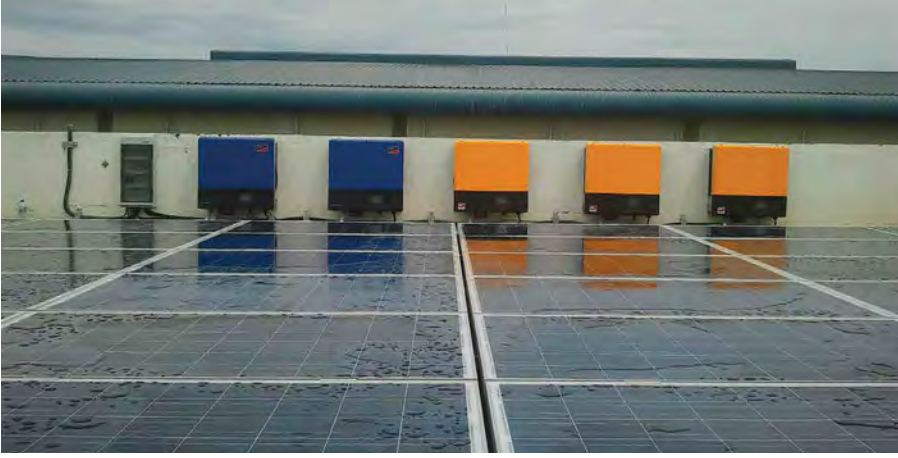
شكل ٢٢: عواكس الشبكة القياسية من أجل اتصال الشبكة أو مولد الديزل
