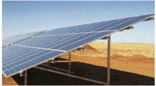
شكل ٨: تركيبات نموذجية أرضية
